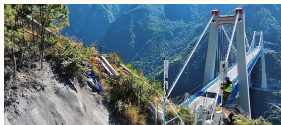
虎跳峡金沙江铁路大桥基站建设
