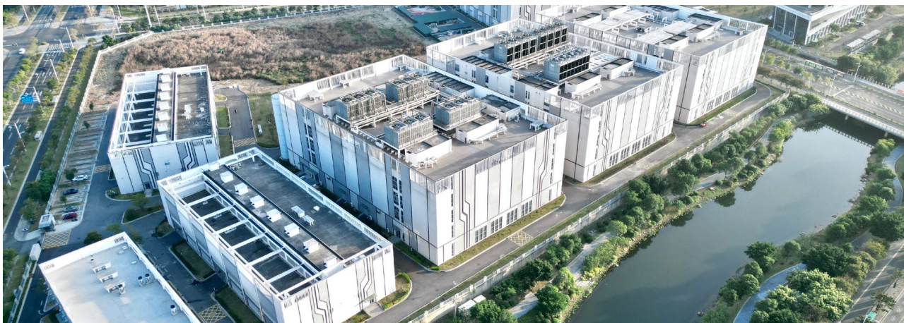
中国移动（福建福州）级超大型数据中心
