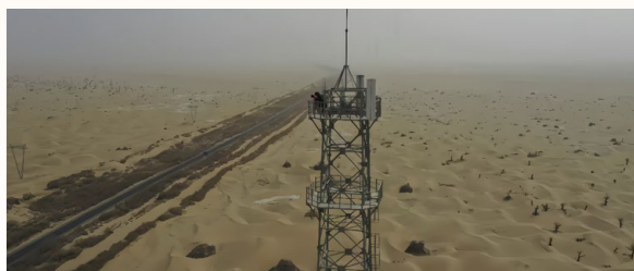
中国移动在新疆开通首个沙漠公路 700MHz 5G 超远覆盖基站
